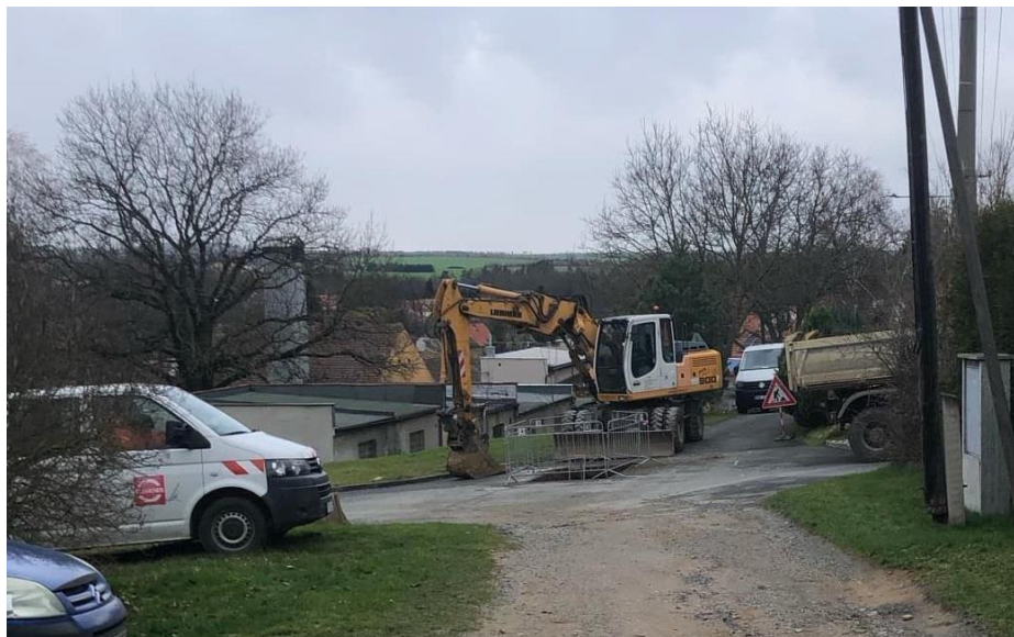
Stavební práce v ulici Ke Cvičišti.
