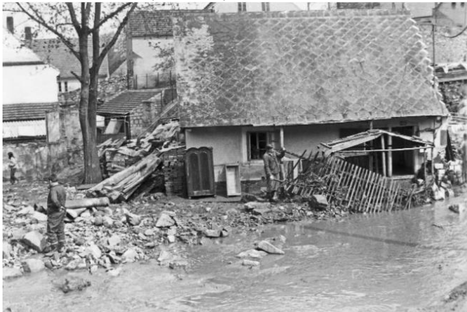
č.p. 62 - 1.5. 1975 následky po povodni z předchozího večera
