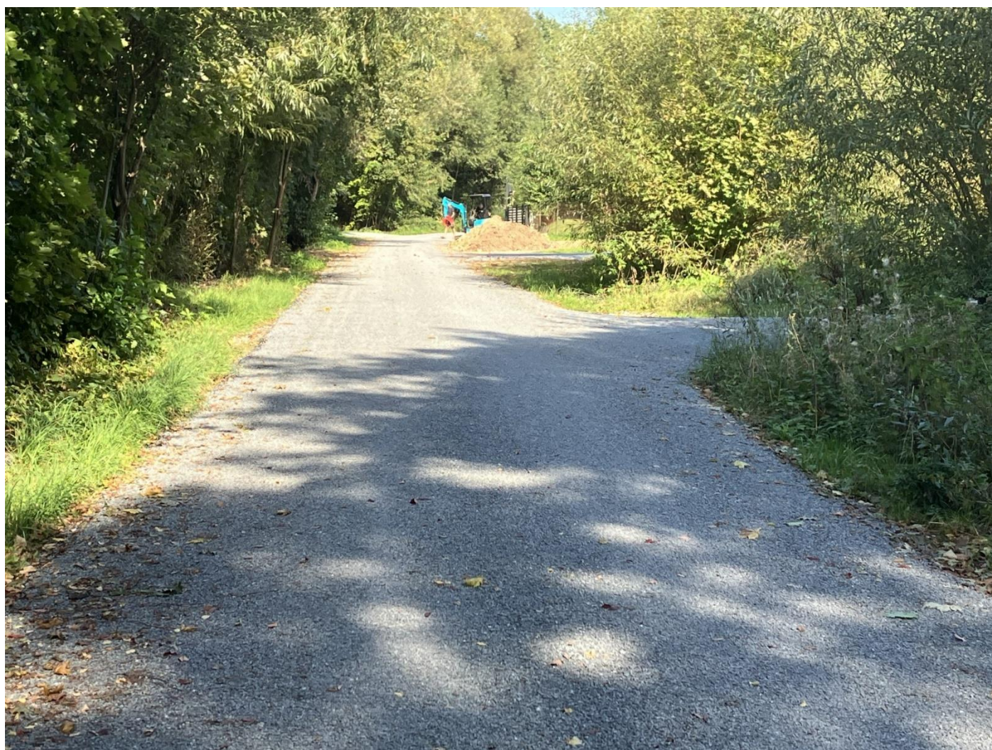
Opravená cesta v ulici V Potocích.
