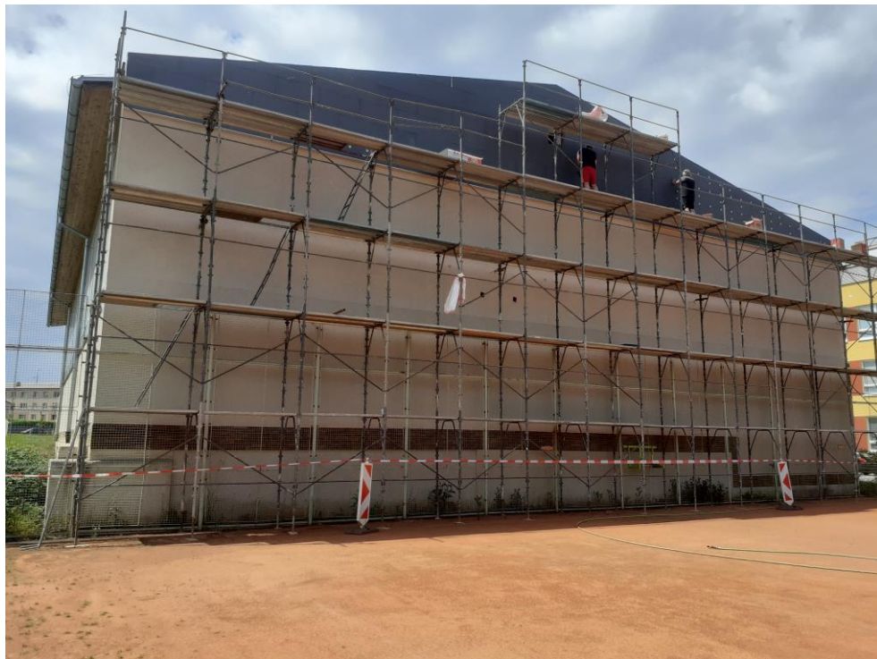
Součástí rekonstrukce je zateplení části štítu budovy.
